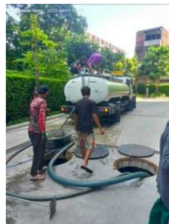
การสูบน้ำส่วนเกินจากระบบบำบัดน้ำเสีย
