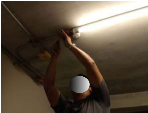
ภาพที่ 2-26 ทำความสะอาดหลอดไฟ
