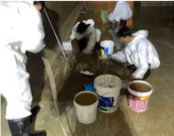
การทำความสะอาดถังเก็บน้ำใช้ ภาพที่ 2-8 (ต่อ) ระบบน้ำใช้ของโครงการ
